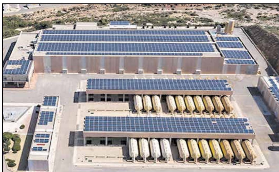
Instalaciones de GS Inima. EE
